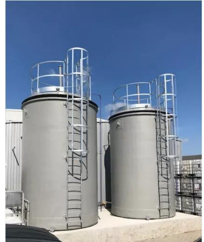
Zbiorniki pionowe wzmocnione włóknem szklanym
