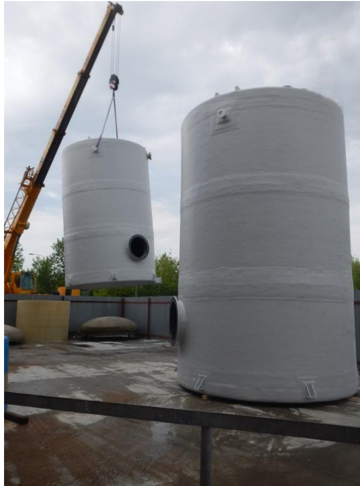
Zbiorniki pionowe wzmocnione włóknem szklanym
